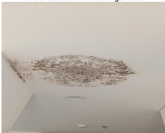
Imagen 2 Cielo raso del área de urgencias
